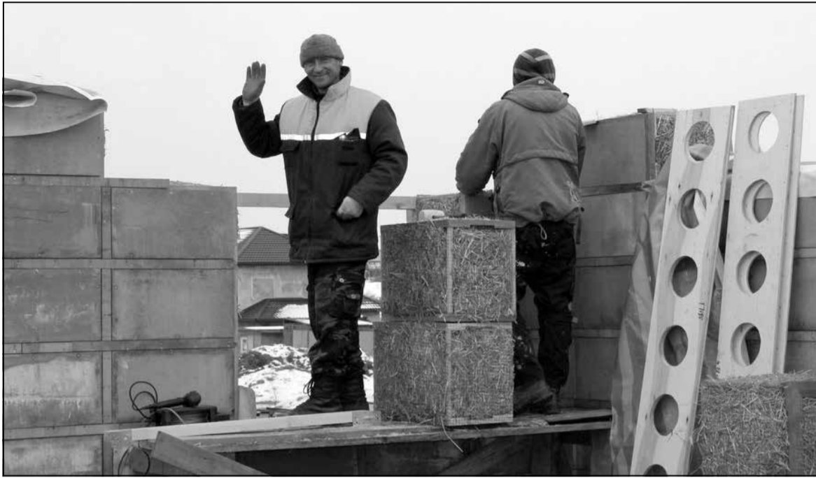
Перад пачаткамі будаўнічых прац рабочыя праходзяць адмысловы інструктаж
